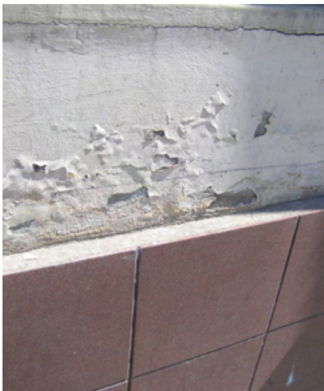
Результат закривання вологих стін плиткою та фарбуванням паронепроникною фарбою
